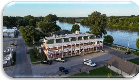
Figure 76- Vista aérea del Hotel Keosauqua Manning junto al acceso al Sendero Acuático y el Circuito del Sendero de Keosauqua
