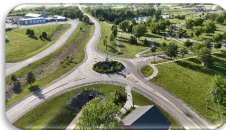
Figure 40- Glorieta sobre la autopista 432 y el paso subterráneo de Pella Ave del sendero
