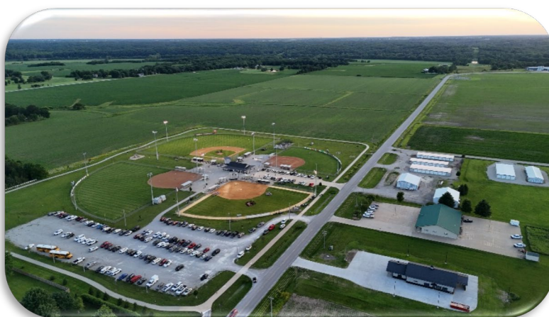
Figure 46- Vista aérea suroeste del complejo deportivo Mildred & Eddie Ferguson.
