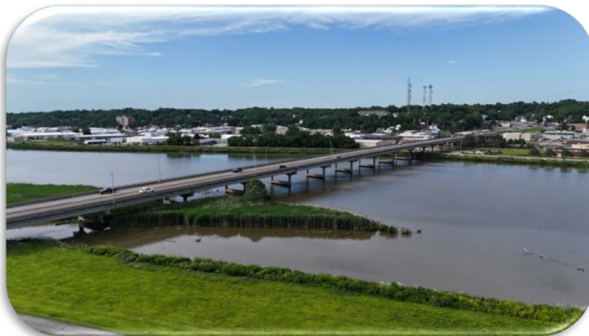
Figure 81- El puente de la autopista 149/carretera comercial 63 se programará para el año fiscal 2031 para su rehabilitación, con la posible construcción de un sendero lateral que conecte con otros caminos.
