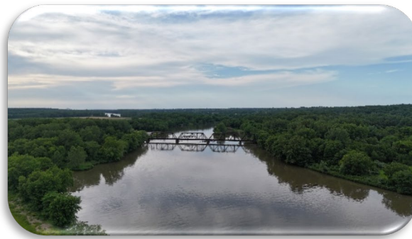
Figure 70- Vista norte del río Des Moines a lo largo de Turkey Island en Ottumwa.
